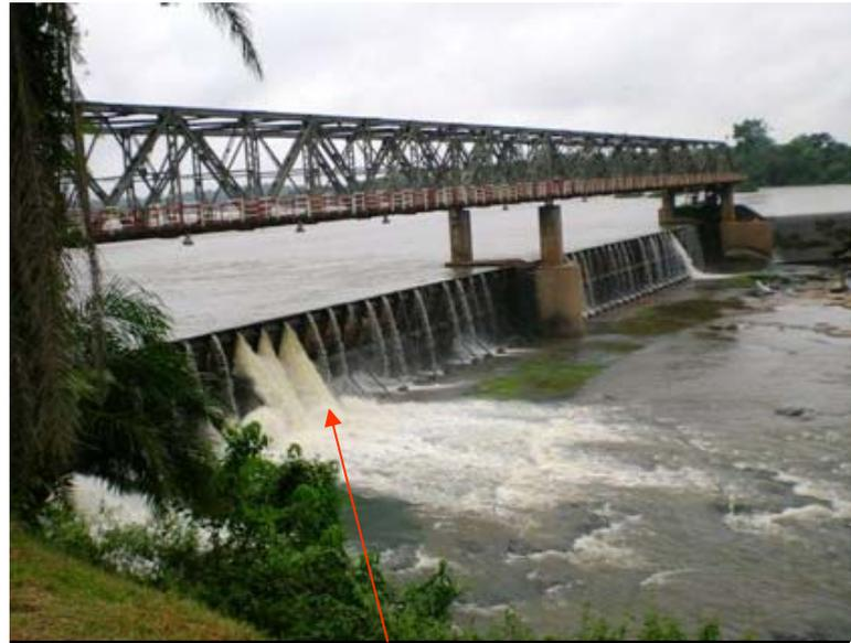
**Vues des hausses mobiles en décembre 2008, avant le début des travaux... avec un mécanisme de retenue d'eau défectueux...**
